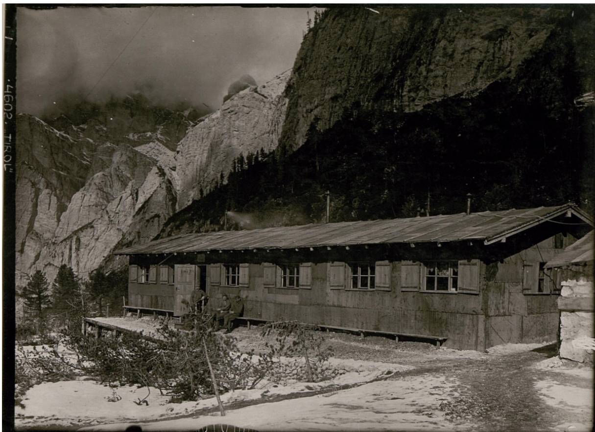
Společenská budova domobraneckého pěšího praporu číslo 167 pod horským masívem Lagazuoi
